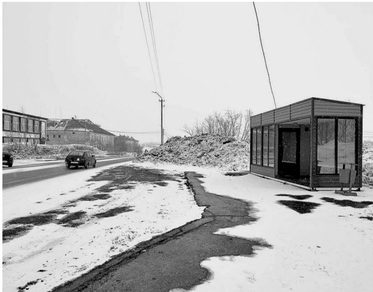
Компания «ВоркутаУголь» установила новый автобусный павильон – на это раз на остановке «Депо». Павильон состоит из двух блоков – открытого и закрытого. Тепло внутри обеспечивают инфракрасные нагревательные панели. Конструкции адаптированы для использования в условиях сурового арктического климата при температуре до -40 °С. Для изготовления остановок задействуются материалы с антивандальными свойствами, а проводка выполнена из негорючего кабеля.
